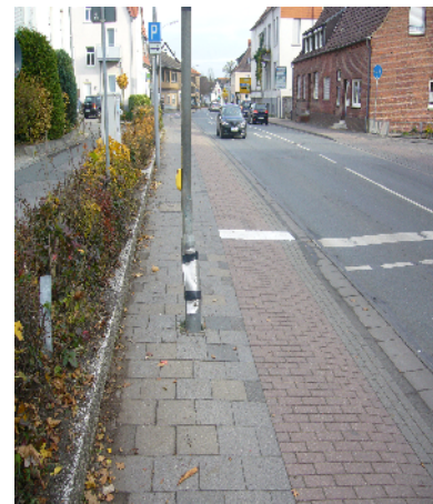
Reparatur nutzen und Ampel umsetzen, fordert die CDU in ihrem Antrag an die Verwaltung
